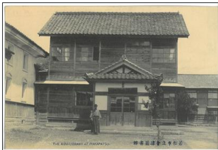
【2階が増築された会津図書館】
